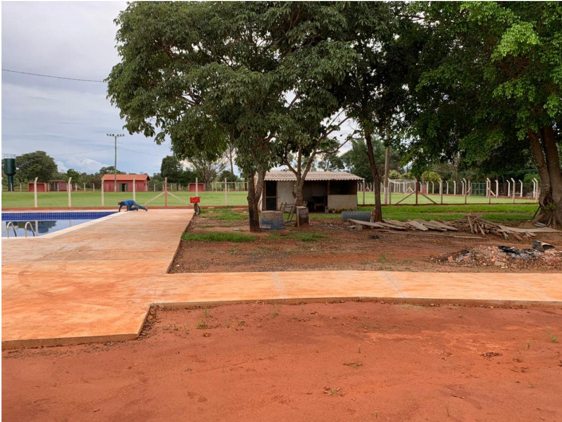
Foto 1: Local da futura construção
