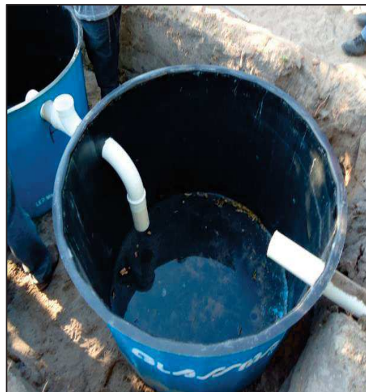
Figura 62 - Exemplo de instalação da fossa biodigestor.
