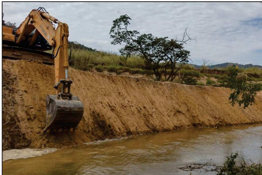
Figura 98- Exemplo de Alargamento e Desassoreamento.
