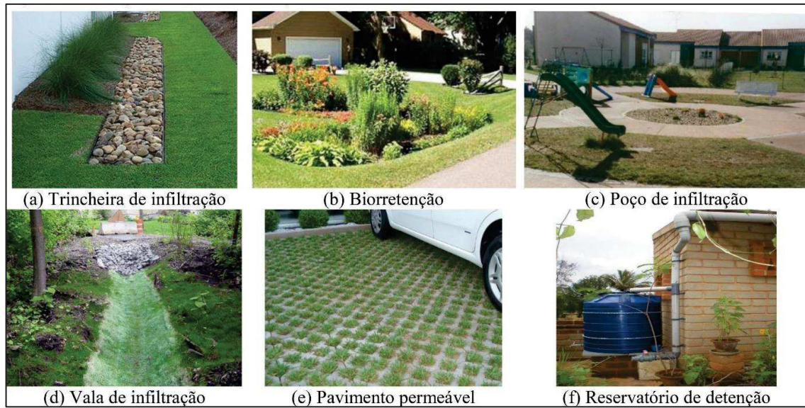
Figura 107 - Exemplos de Controles na Fonte.
