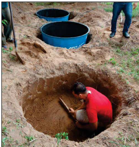
Figura 62 - Exemplo de instalação da fossa biodigestor.
