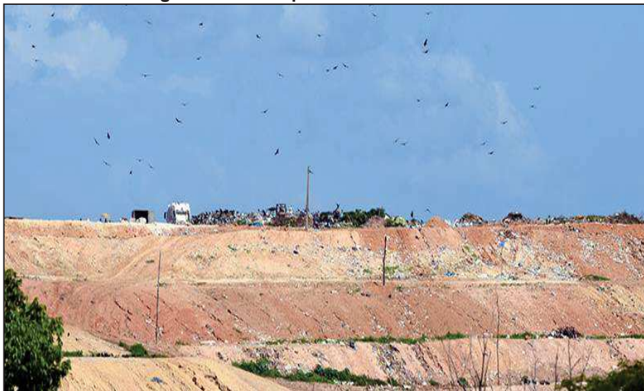
Figura 44 - Exemplo de aterro controlado.
