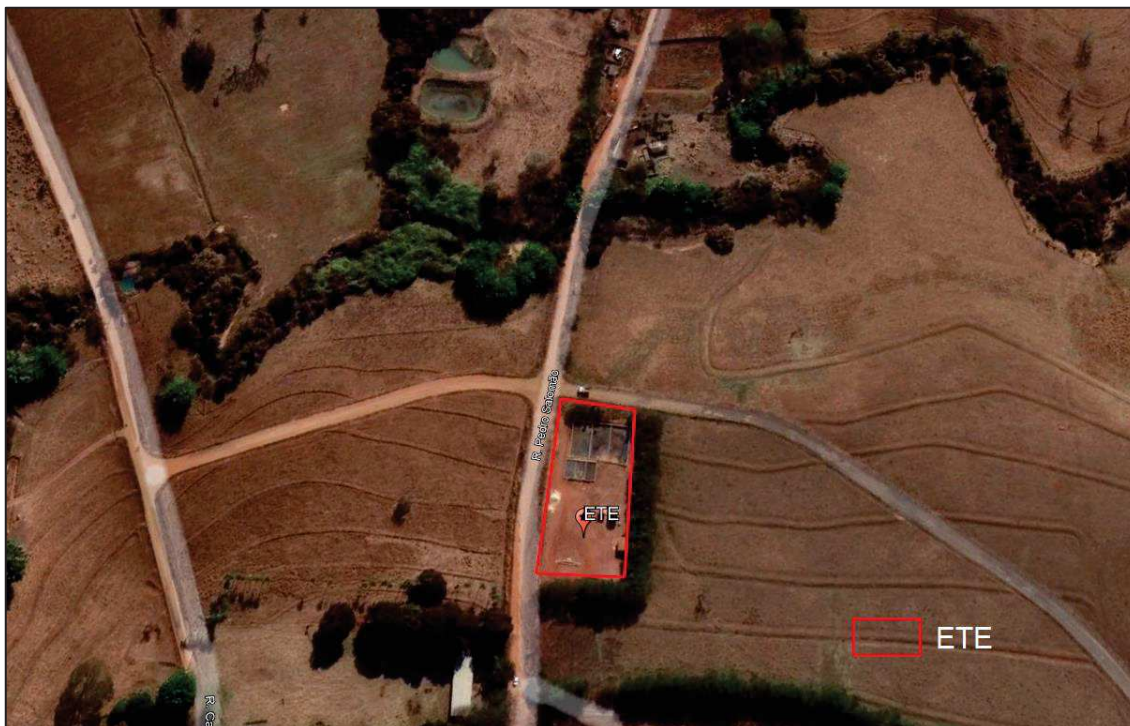
Figura 23 - Localização da ETE de Veríssimo.
