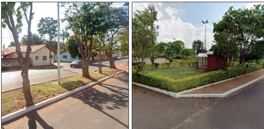
Figura 30 - Locais com boa execução dos serviços de varrição e poda.
